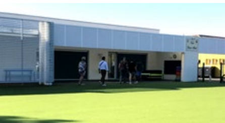
École : changement du chauffage
