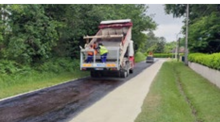
Rue de Pey Lacanau : réfection de la voirie
